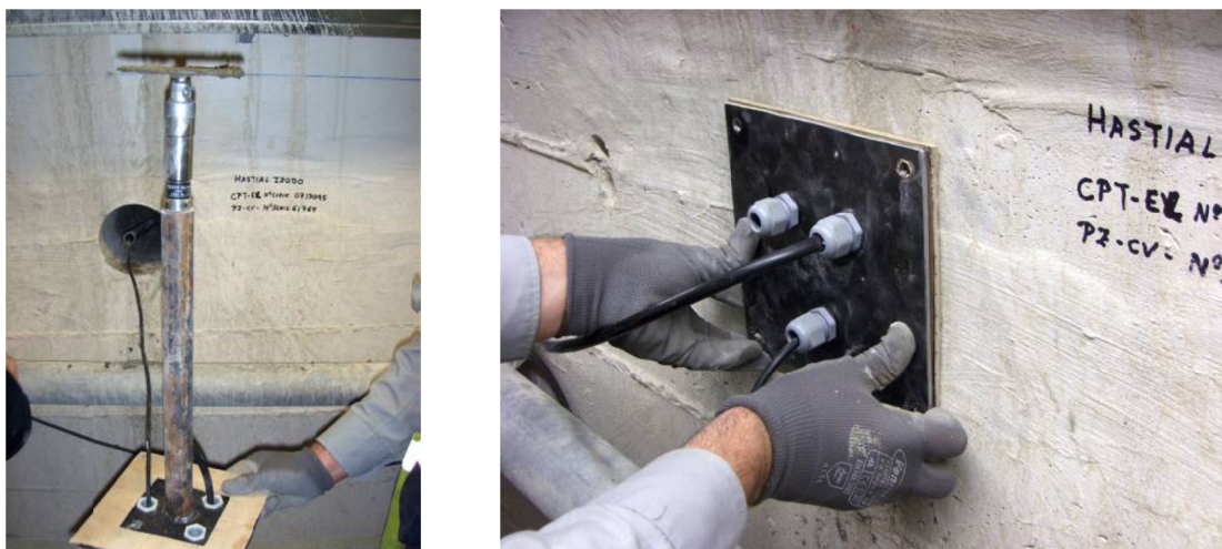
Figur 41 Uppkopplad tryckcells sensor färdig för installation (vänster). Sensorn sätts in i borrhålet (höger).
